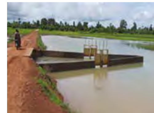
Ouvrage anti-sel, vallée de Samiron.
