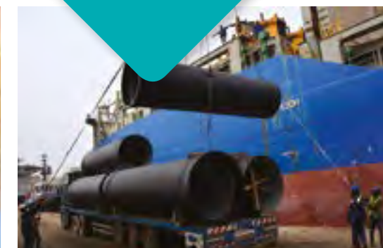
Dernière étape de déchargement avant le démarrage effectif des travaux.
